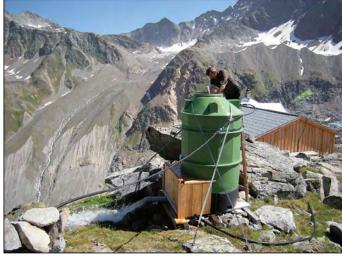
Reinigung des Trinkwasserbehälters; der Zulauf kommt von oben vom Gletscher.
