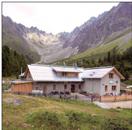
Die neue Verpeilhütte
